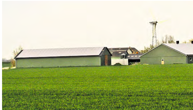
Zu den Einnahmen aus selbständiger Tätigkeit zählen auch Verdienste durch eine Solaranlage. Bei entsprechender Höhe der Einnahme können Krankenkassenbeiträge fällig werden. Foto: Walter Eggensglüß
